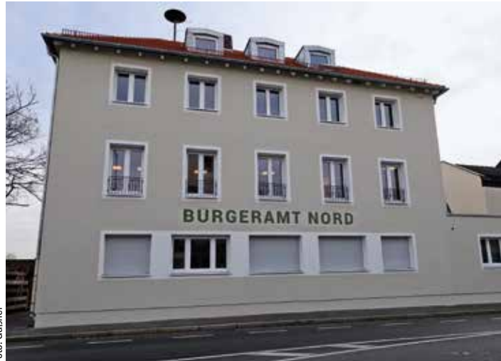
Auch von außen mit dem vorherigen Zustand nicht mehr zu vergleichen – das frisch sanierte Bürgeramt Nord in Stadeln.
