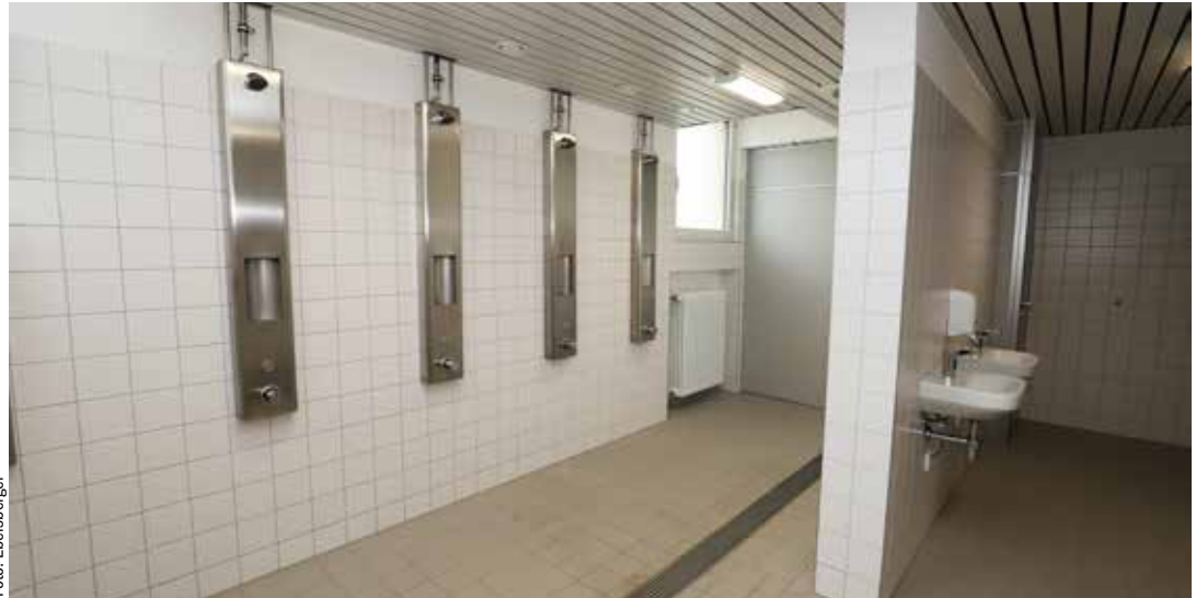
Endlich: Die Sanierungsarbeiten an der Soldnerhalle samt barrierefreien Zugang sind abgeschlossen.
