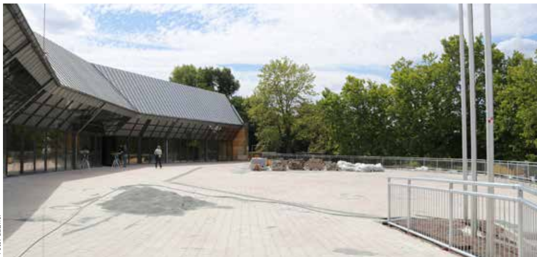
Endspurt: Die Arbeiten für die Terrasse sind bald beendet. Dann kann die neugestaltete Außenfläche für Veranstaltungen in der Stadthalle genutzt werden.
