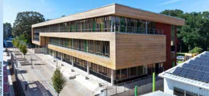
Einsatz energieeffizienter Gebäudetechnik zugunsten guter Lernbedingungen im Neubau der Otto-Seeling Mittelschule durch ein nachhaltiges Zusammenspiel von Wärmepumpe, PV-Modulen und Erdwärme.
