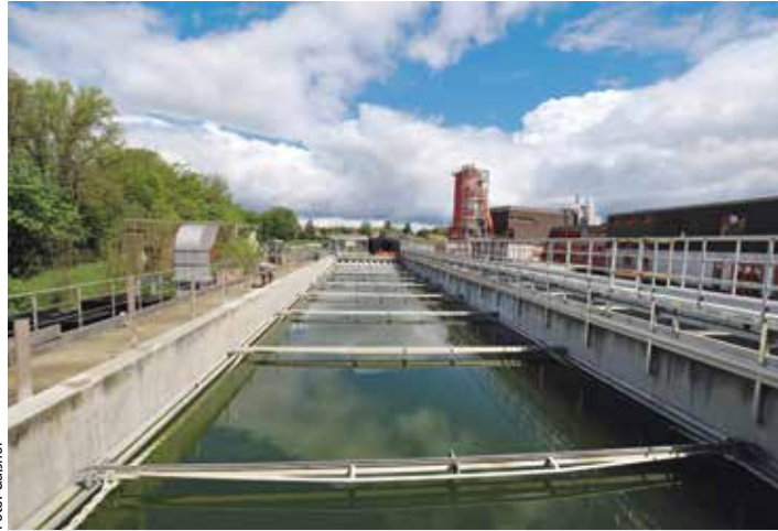
Der Neubau der Hauptkläranlage mit allen Anlagenteilen soll noch in diesem Jahr in Betrieb gehen.
